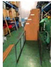
③側面板の正面のジョイントにパイプ枠を繋ぎます。
